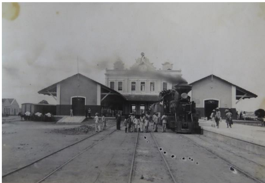
Figura 4 – Estação de trem, Juazeiro-Bahia.
